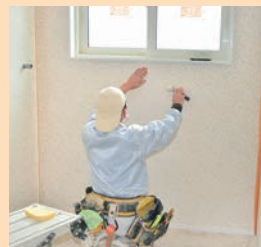
内装材・外装材 設計・改修
