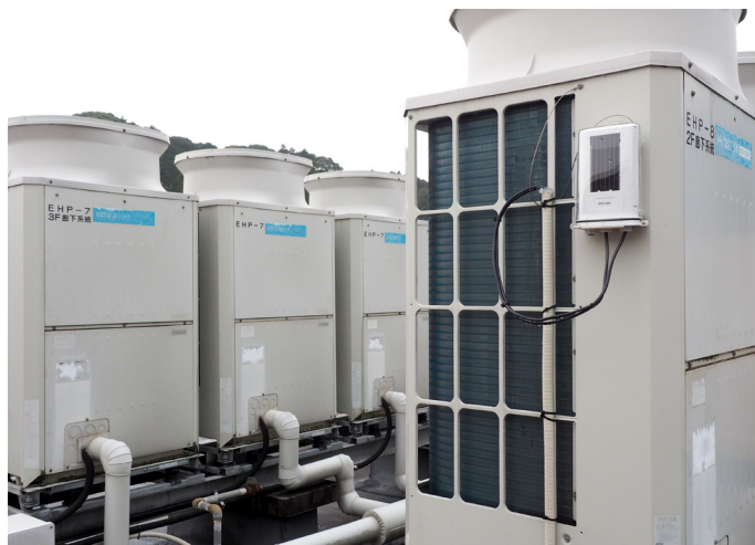
屋上に並んだ空調の室外機。右上に見える小さな白いボックスがEMSの制御子機
